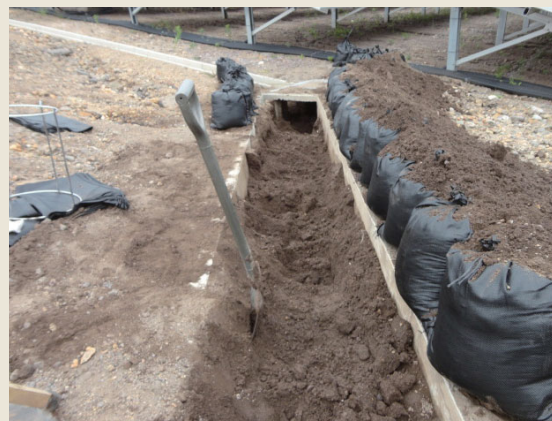
堆積した土砂の撤去は健全に発電所を維持するためには重要である
